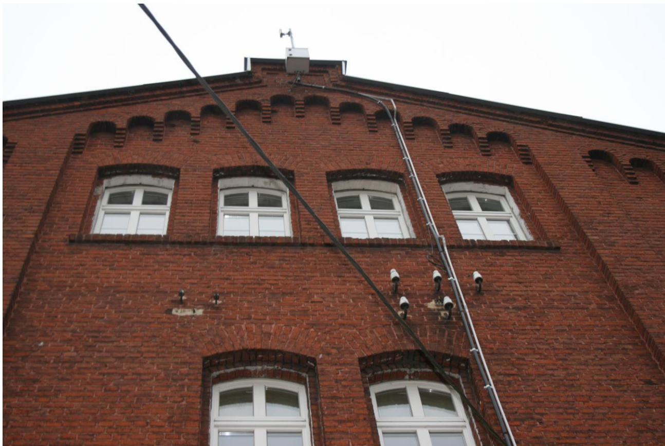
Zdj.17. Pozostałości wcześniejszych instalacji elektrycznych- wsporniki z ceramicznymi izolatorami
