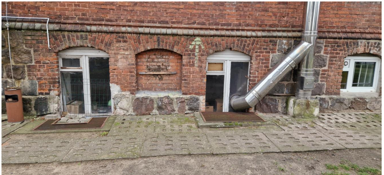
Zdj.24. Zdegradowane krawędzie cegieł w nadprożach łukowych od strony zachodniej
