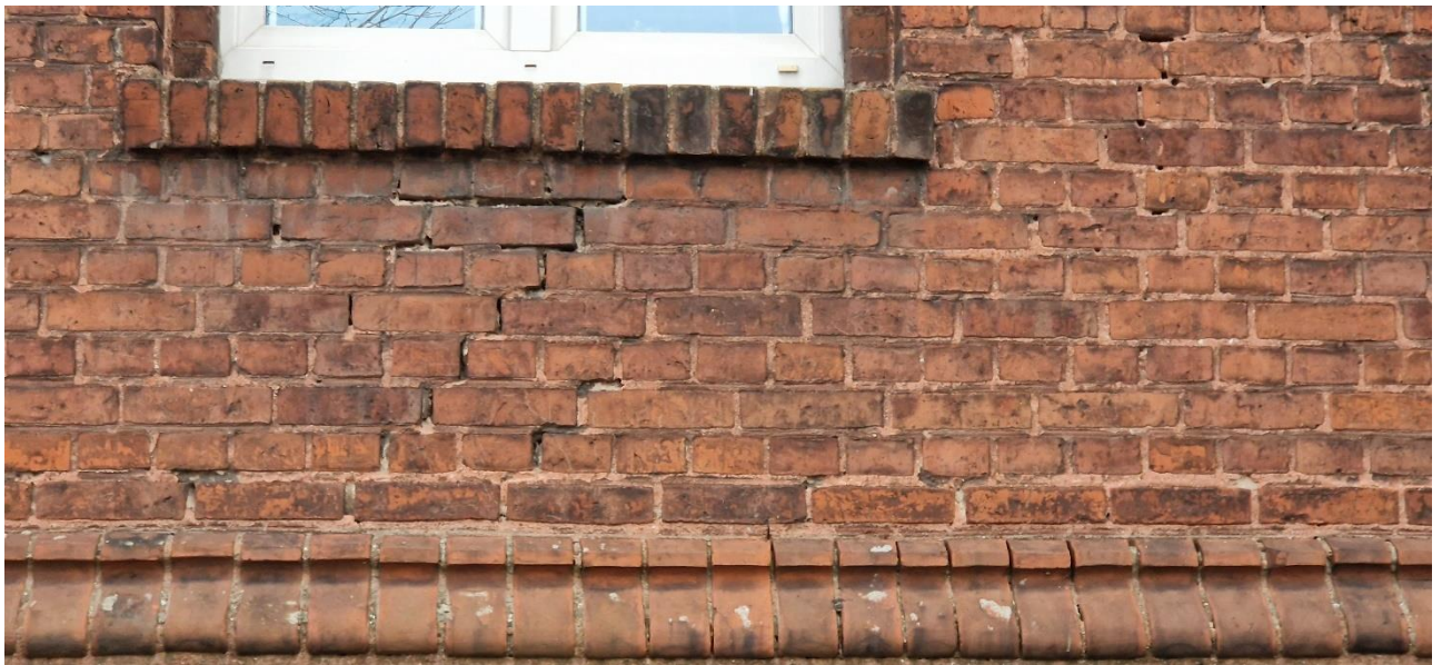
Zdj.23. Zarysowania muru od strony zachodniej
