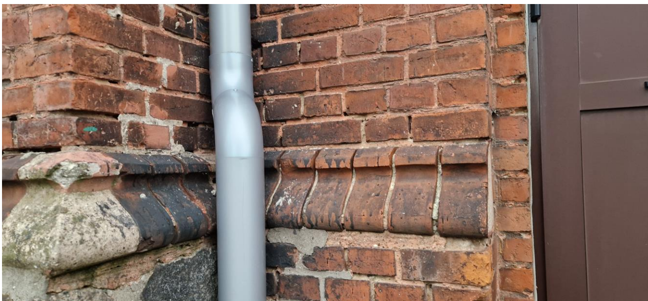
Zdj.38.Stan zachowania lica kształtek ceramicznych rolki nad cokołem kamiennym
