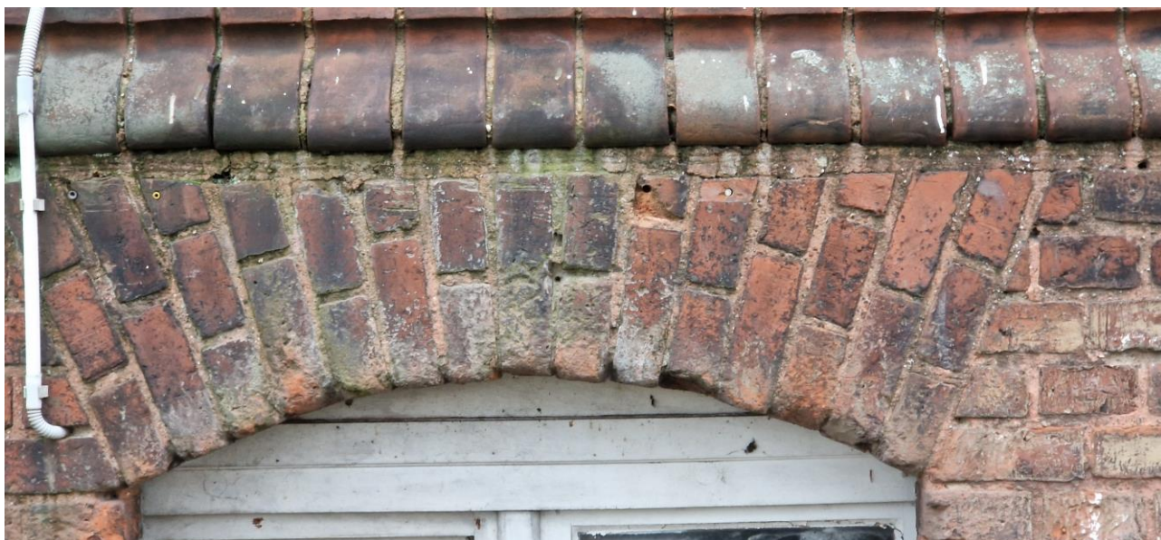
Zdj.27. Zdegradowane krawędzie cegieł w nadprożach łukowych od strony zachodniej
