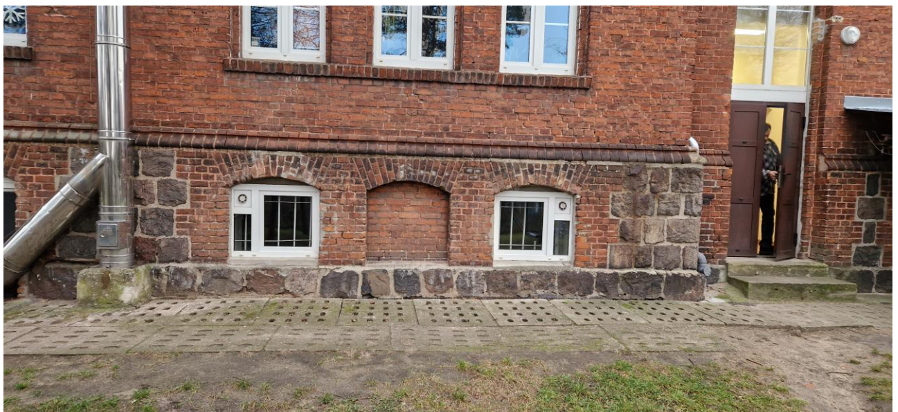
Zdj.25. Zdegradowane krawędzie cegieł w nadprożach łukowych od strony zachodniej
