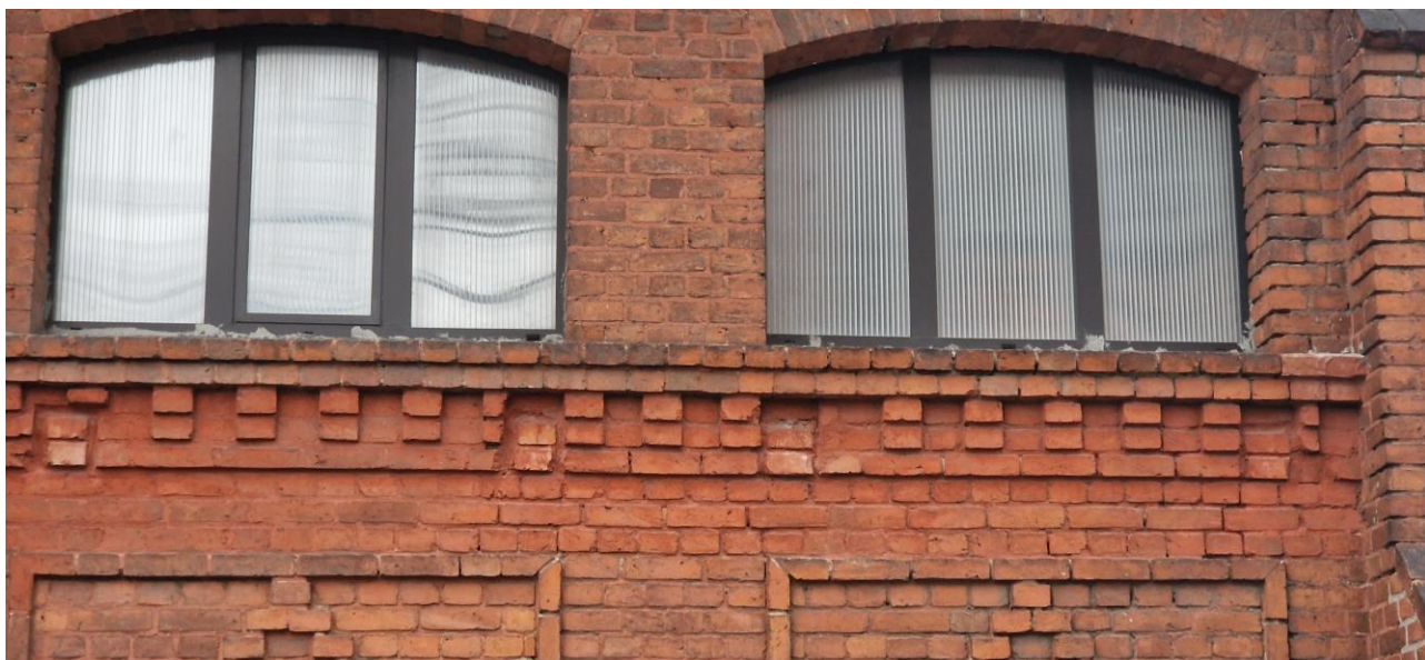
Zdj.48.Ubytki gzymsu
