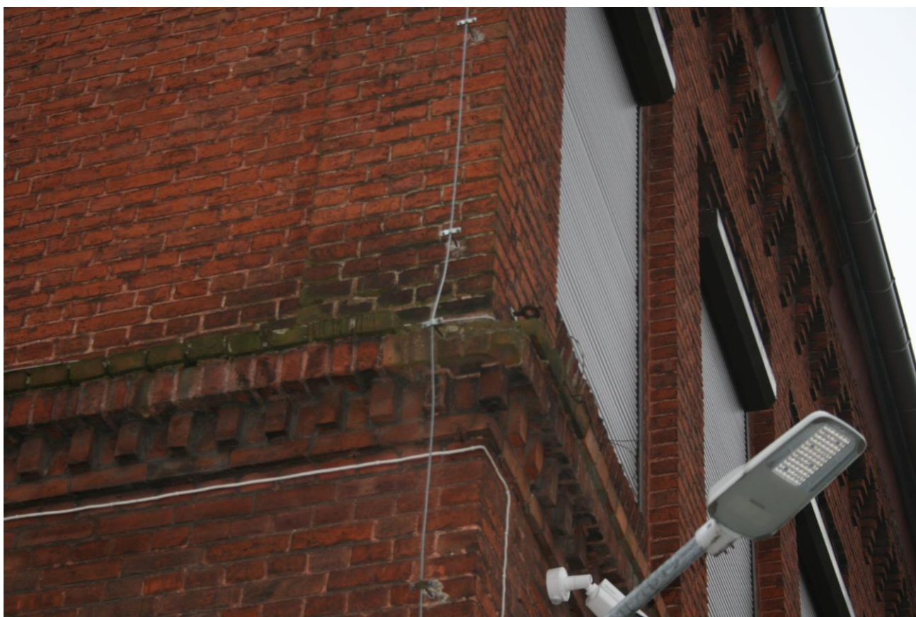
Zdj.18. Ubytki cegieł w gzymsie między kondygnacyjnym od strony południowo-zachodniej
