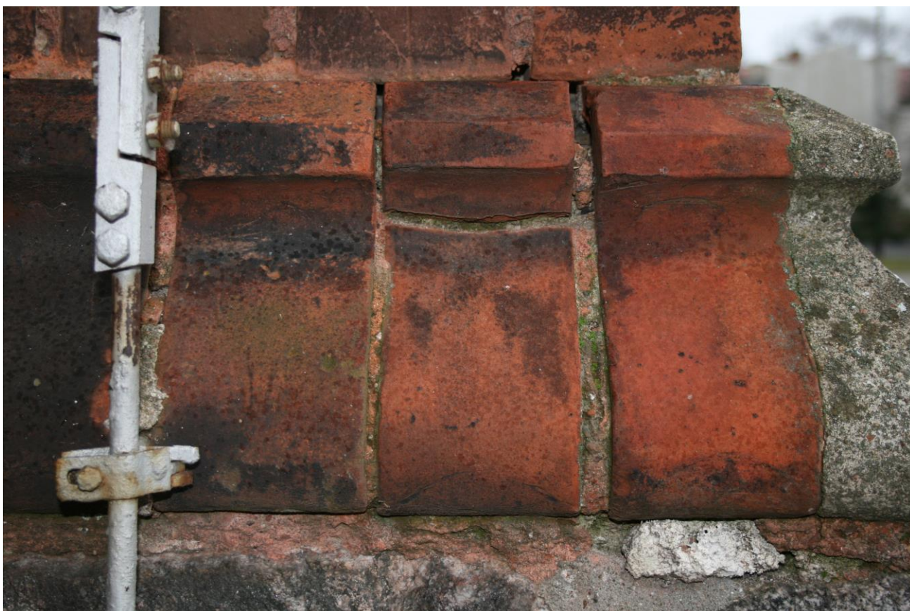
Zdj.11. Rolka nad cokołem – widoczne uszkodzenia, ubytki spoin, zabrudzenia
