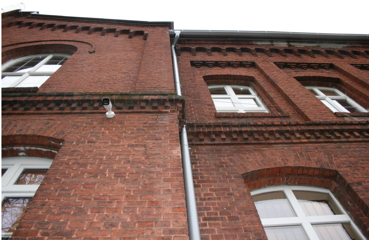
Zdj.31. Zdegradowany gzyms między kondygnacyjny od strony elewacji zachodniej
