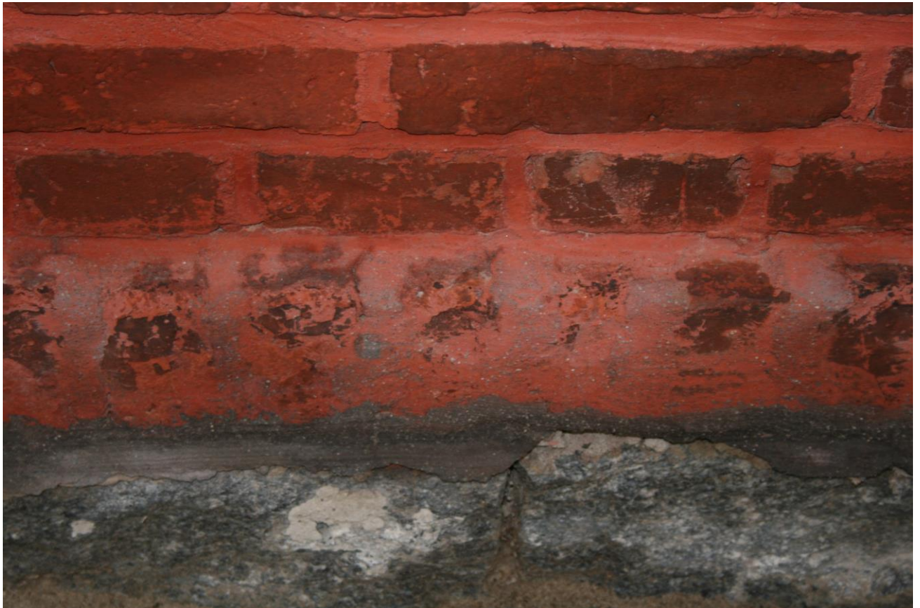
Zdj.53.Elewacja wschodnia (wejście główne) – wtórne wypełnienie spoin rolki cokołowej, zaciemniony wątek. Widoczna powłoka malarska elewacji.
