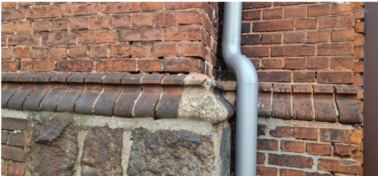
Zdj.37.Stan zachowania rolki i muru nad cokołem kamiennym
