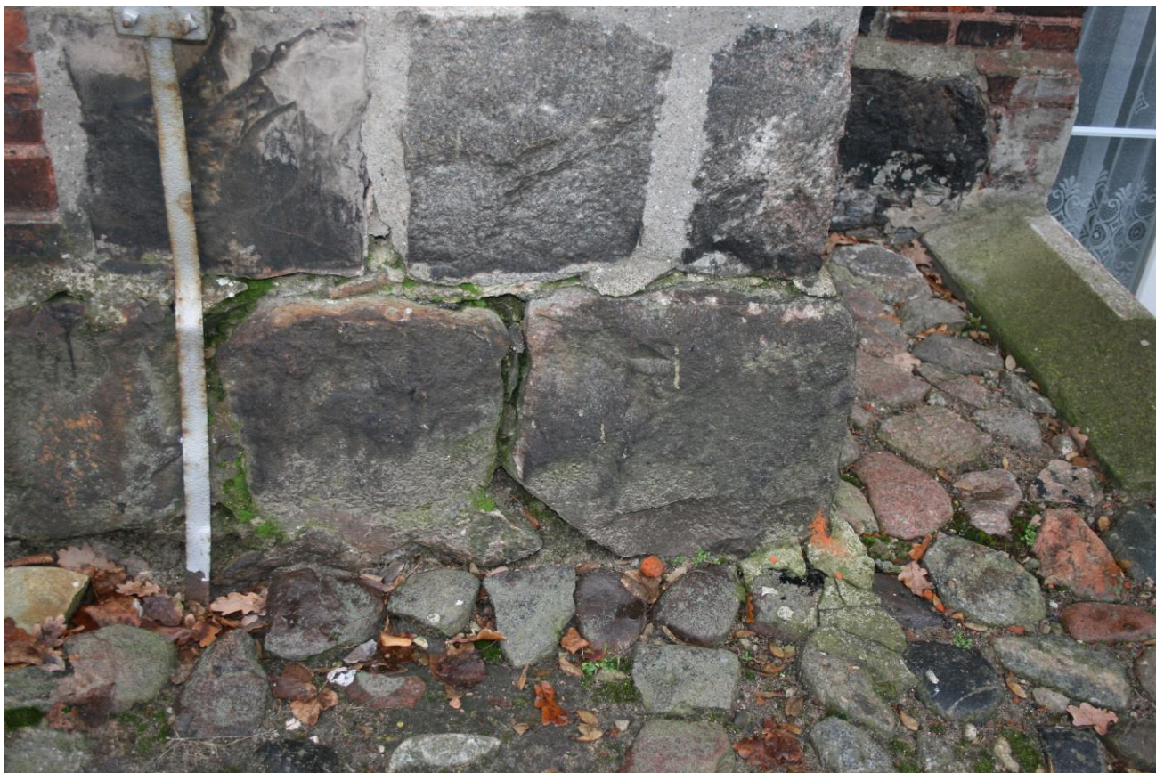
Zdj.15. Ubytki i korozja spoin cokołu kamiennego.
