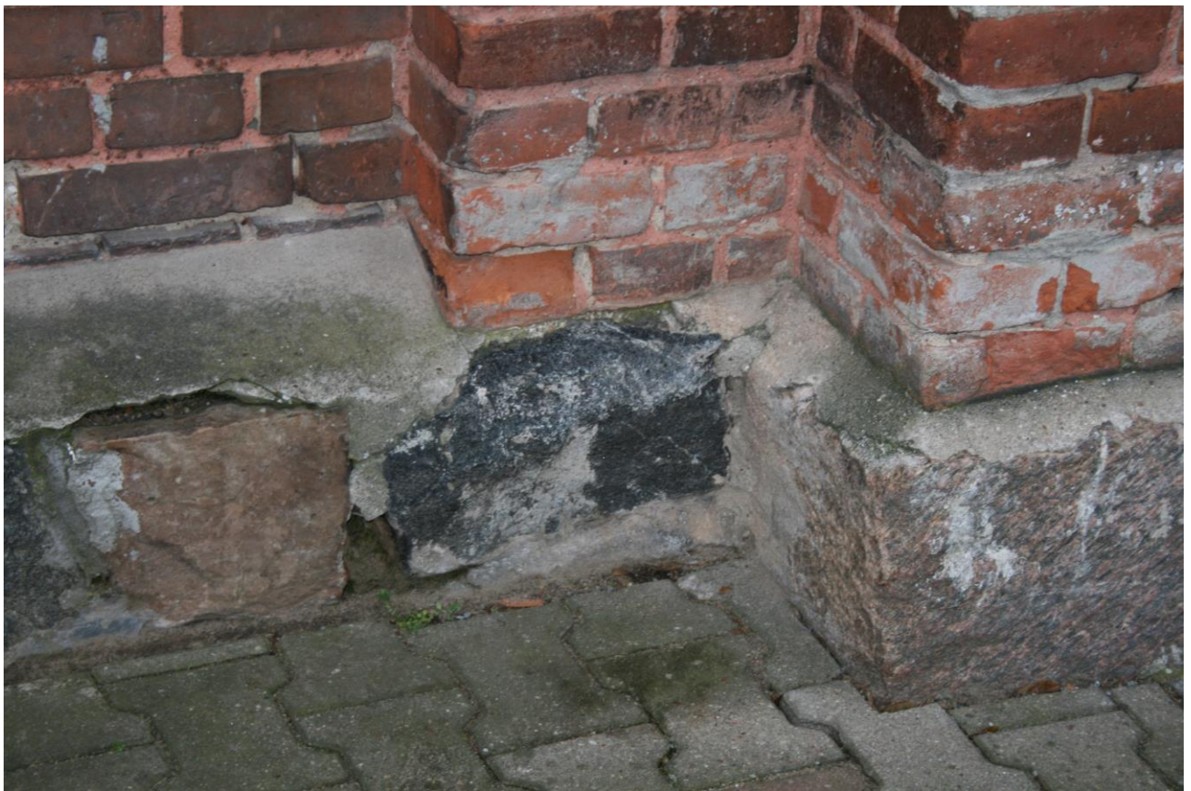
Zdj.13. Ubytki spoin i zniszczenia spływu cokołu kamiennego.
