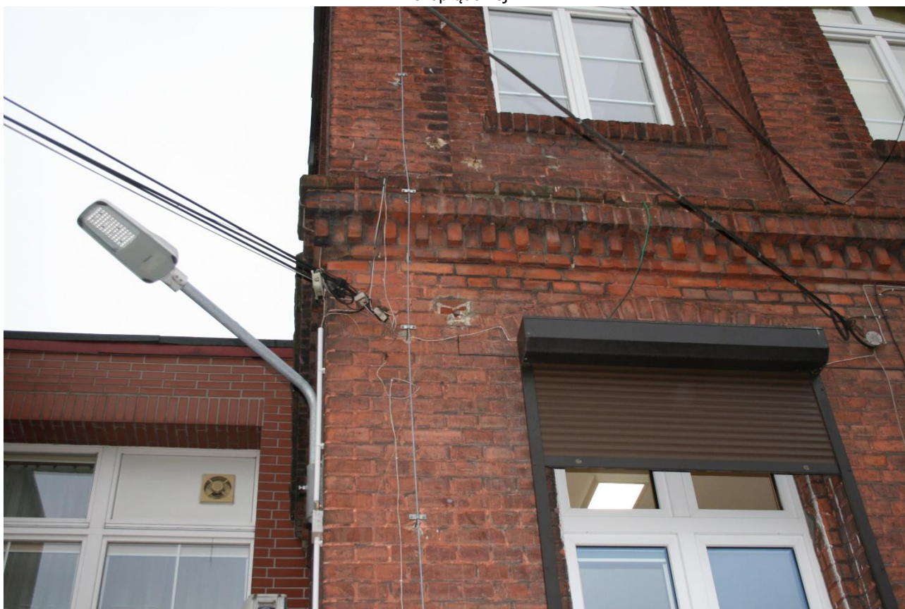
Zdj.9. Ubytki cegieł i spoinowania w gzymsie między kondygnacyjnym. Widoczny również brak uporządkowania instalacji niskoprądowej.
