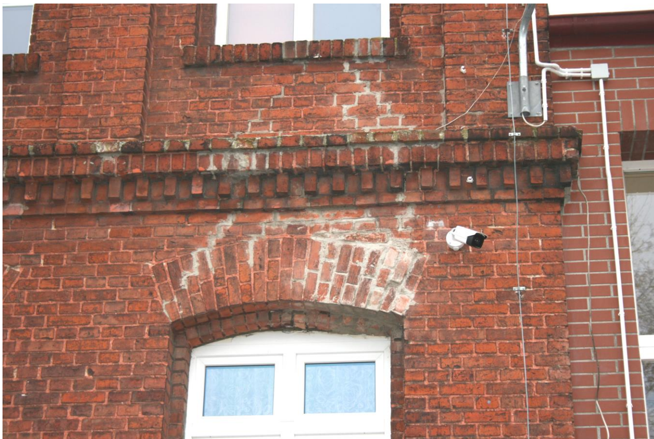
Zdj.35. Wtórne przemuirowanie wātku – naprawa zarysowań nadproża i muru
