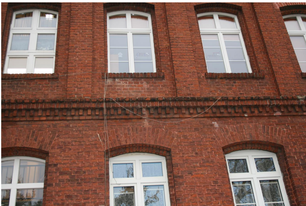
Zdj.36. Stan zachowania elewacji oraz chaotyczny i przypadkowe rozprowadzenie instalacji niskoprądowej
