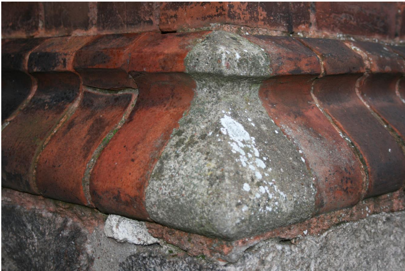
Zdj.10. Narożnik rolki nad cokołowej – widoczne uszkodzenia, ubytki spoin, zabrudzenia
