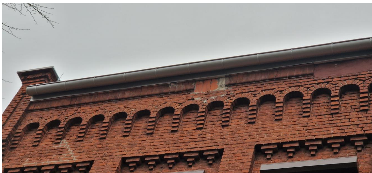
Zdj.20. Ubytki lic kształtek ceramicznych w gzymsie okapowym oraz wypłukane spoiny od strony zachodniej
