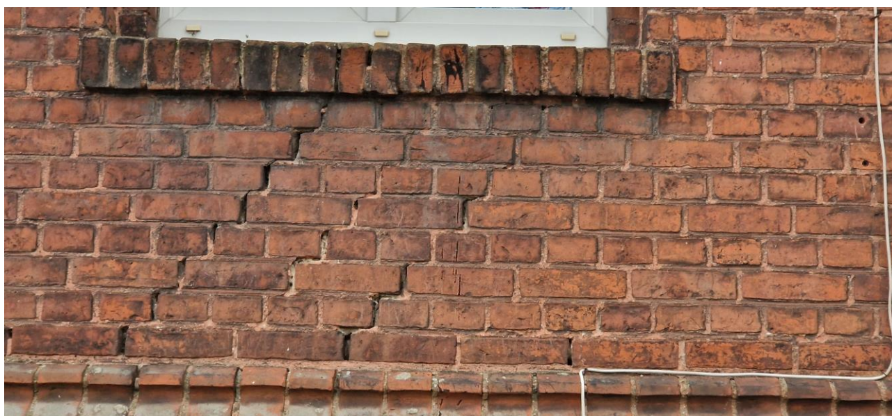
Zdj.22. Zarysowania muru od strony zachodniej
