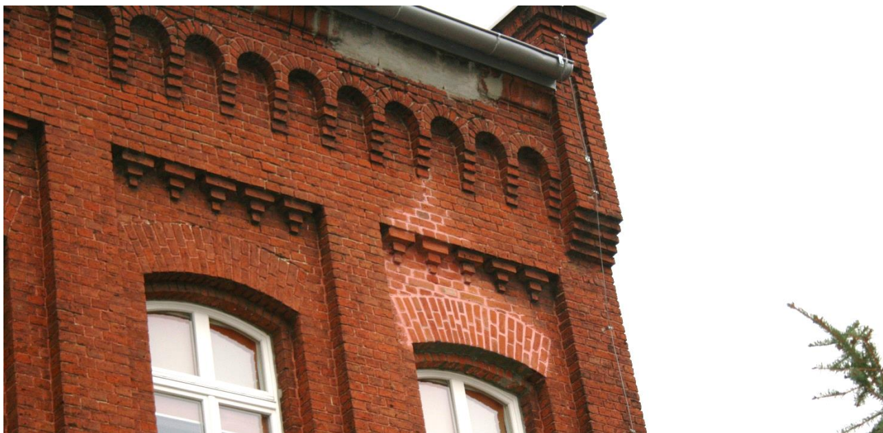
Zdj.32. Wtórne przemurowania wążku nadproża. Widoczne ubytki gzymsu okapowego, uzupełnione zaprawą cementową
