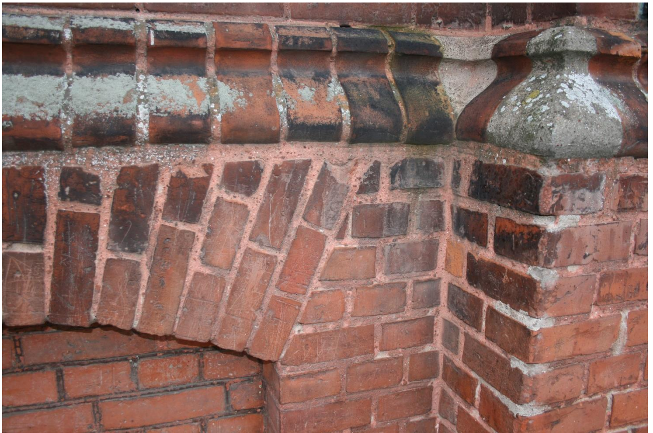
Zdj.12. Ściana cokołu – widoczna degradacji spoin. Widoczne zabrudzenia elewacji.
