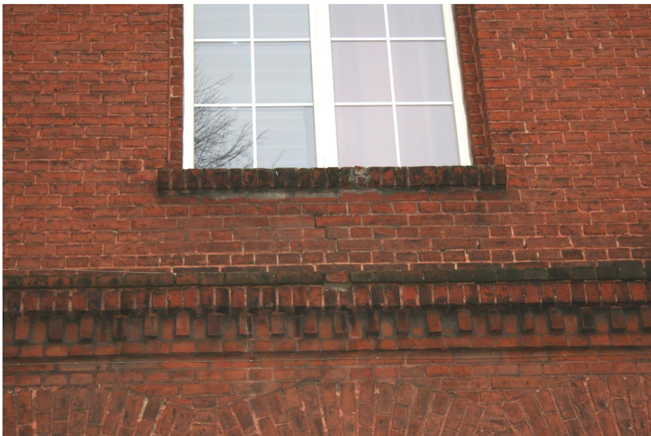
Zdj.29. Zarysowania muru od strony zachodniej
