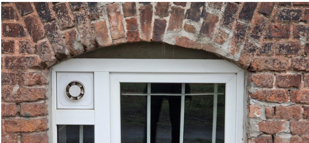
Zdj.28. Zdegradowane krawędzie i lica cegieł w nadprożach łukowych od strony zachodniej
