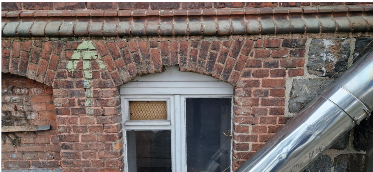
Zdj.26. Zdegradowane cegły w nadprożach łukowych od strony zachodniej
