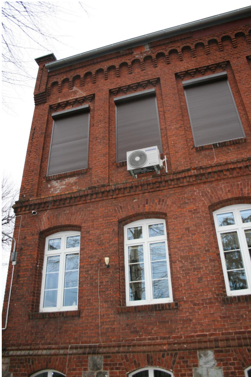
Zdj.19. Ubytki lic kształtek ceramicznych w gzymsie okapowym oraz zarysowania ścian od strony zachodniej
