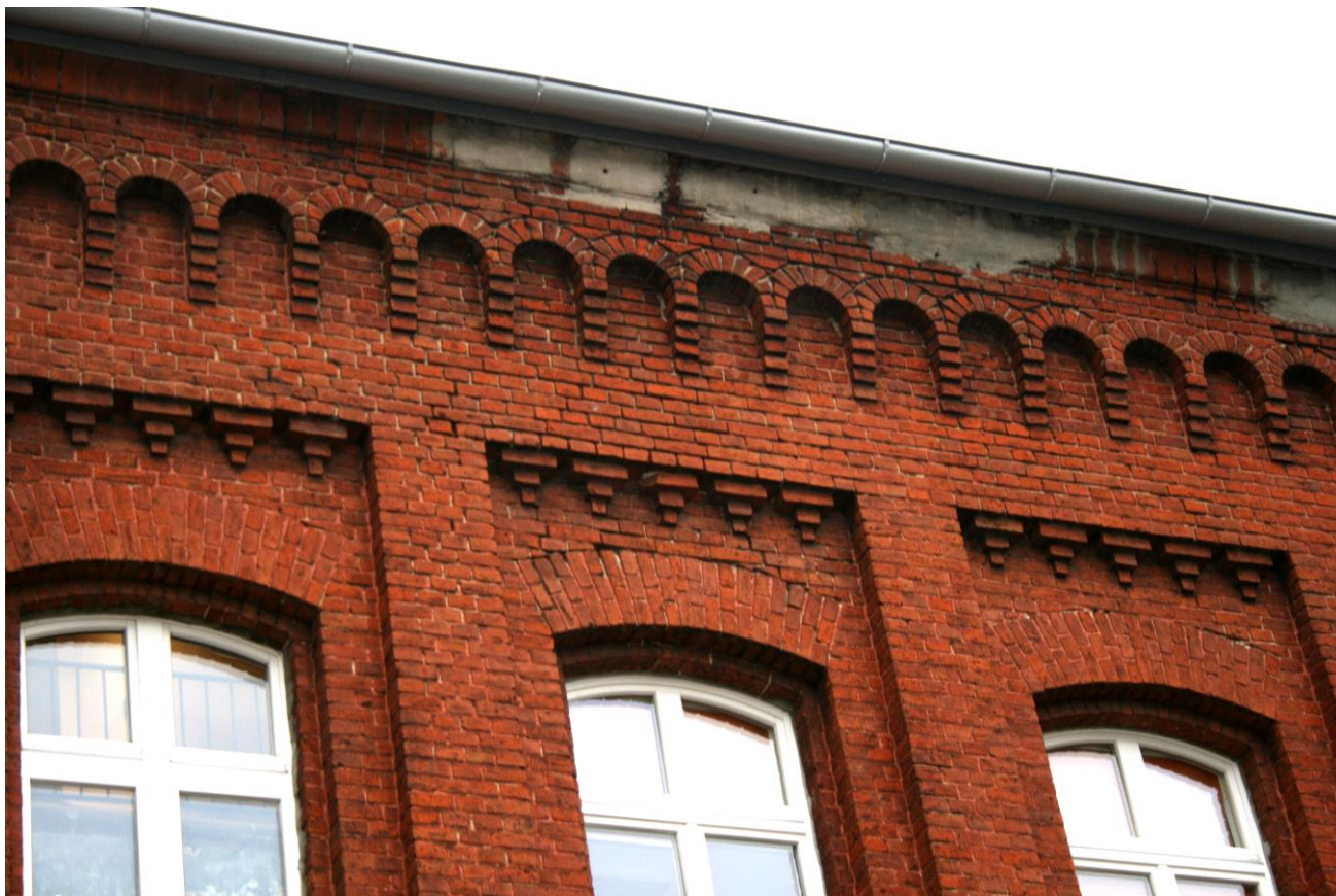
Zdj.33. Ubytki ceramicznych kształtek gzymsu okapowego uzupełnione zaprawą cementową
