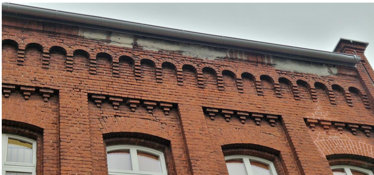
Zdj.34. Ubytki ceramicznych kształtek gzymsu okapowego uzupełnione zaprawą cementową
