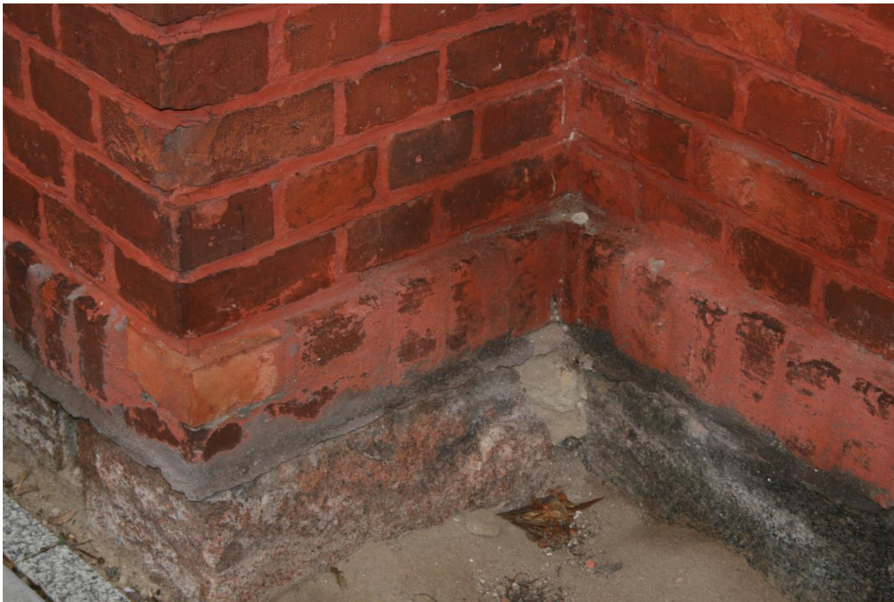
Zdj.54.Elewacja południowa – wtórne wypełnienie spoin rolki cokołowej, zaciemniony wątek. Widoczna powłoka malarska elewacji.
