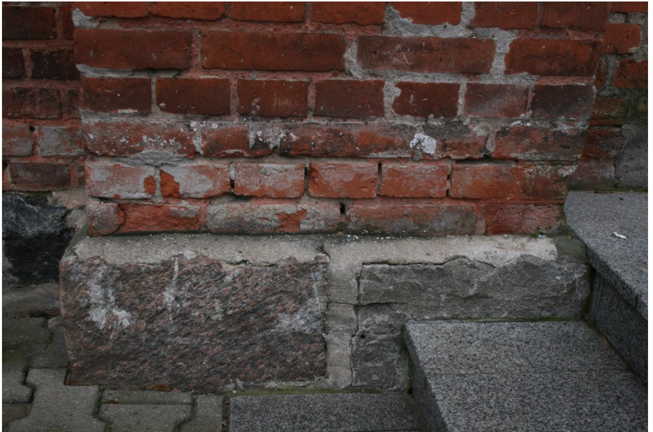
Zdj.13. Korozja spoin cokołu kamiennego oraz korozja solna cegieł nad cokołem.
