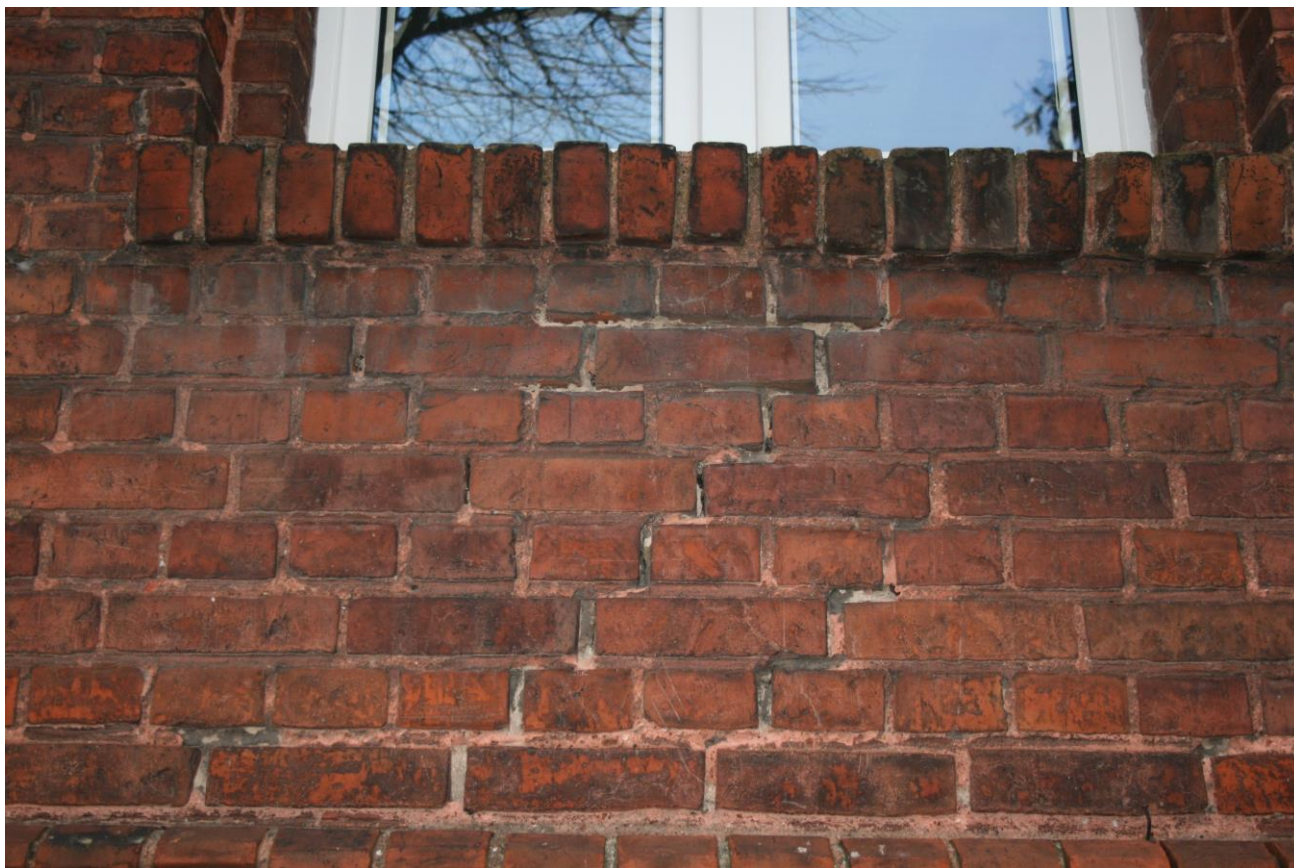
Zdj.21. Zarysowania muru od strony zachodniej
