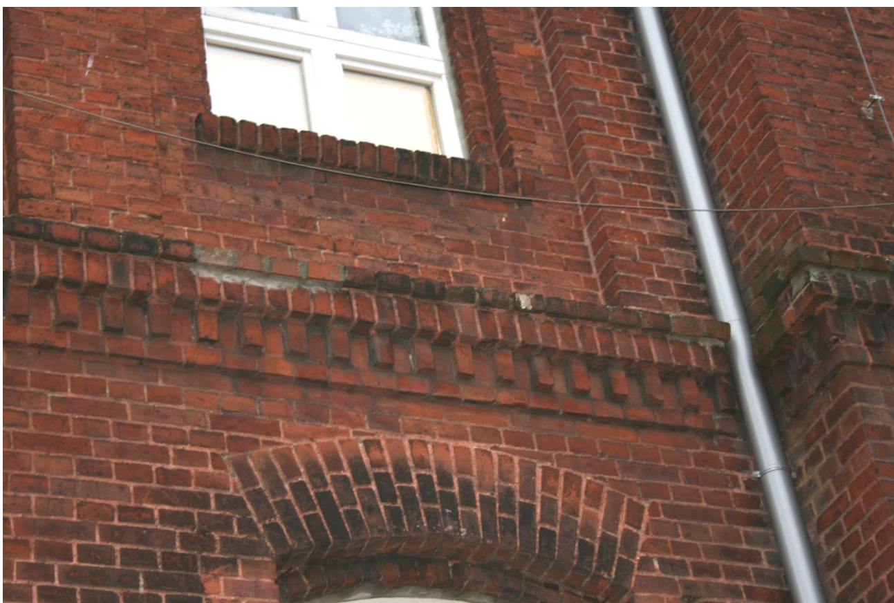
Zdj.20. Przemurowania wtórne gzymsu między kondygnacyjnego od strony zachodniej
