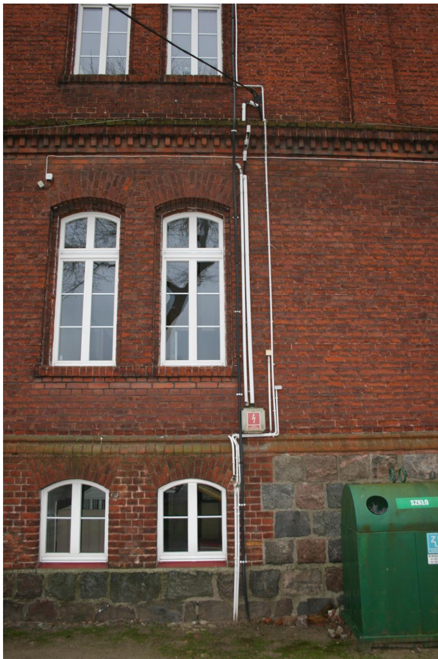
Zdj.16. Nieuporządkowane instalacje elektro-energetyczne na elewacji północnej.
