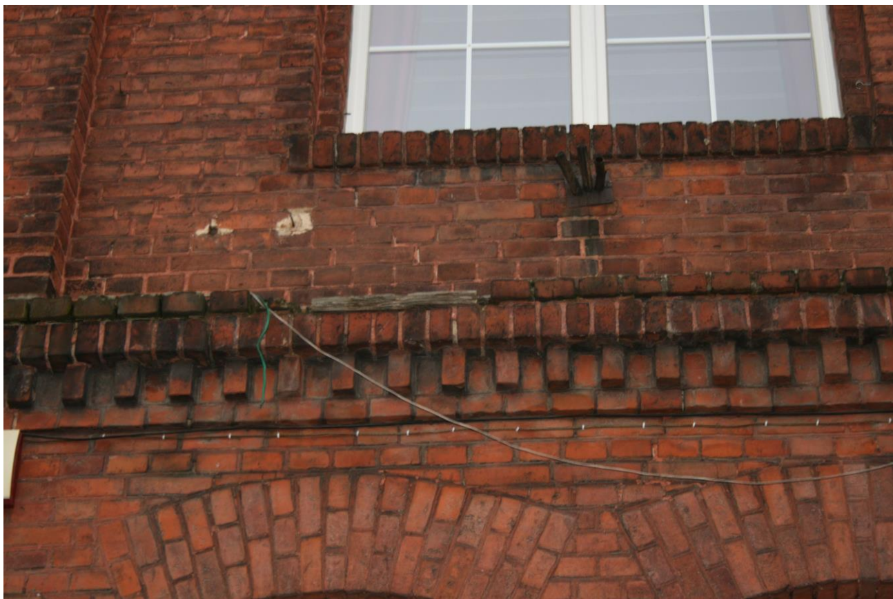
Zdj.6. Ubytki cegieł i spoinowania w gzymsie między kondygnacyjnym. Widoczny również brak uporządkowania instalacji niskoprądowej.
