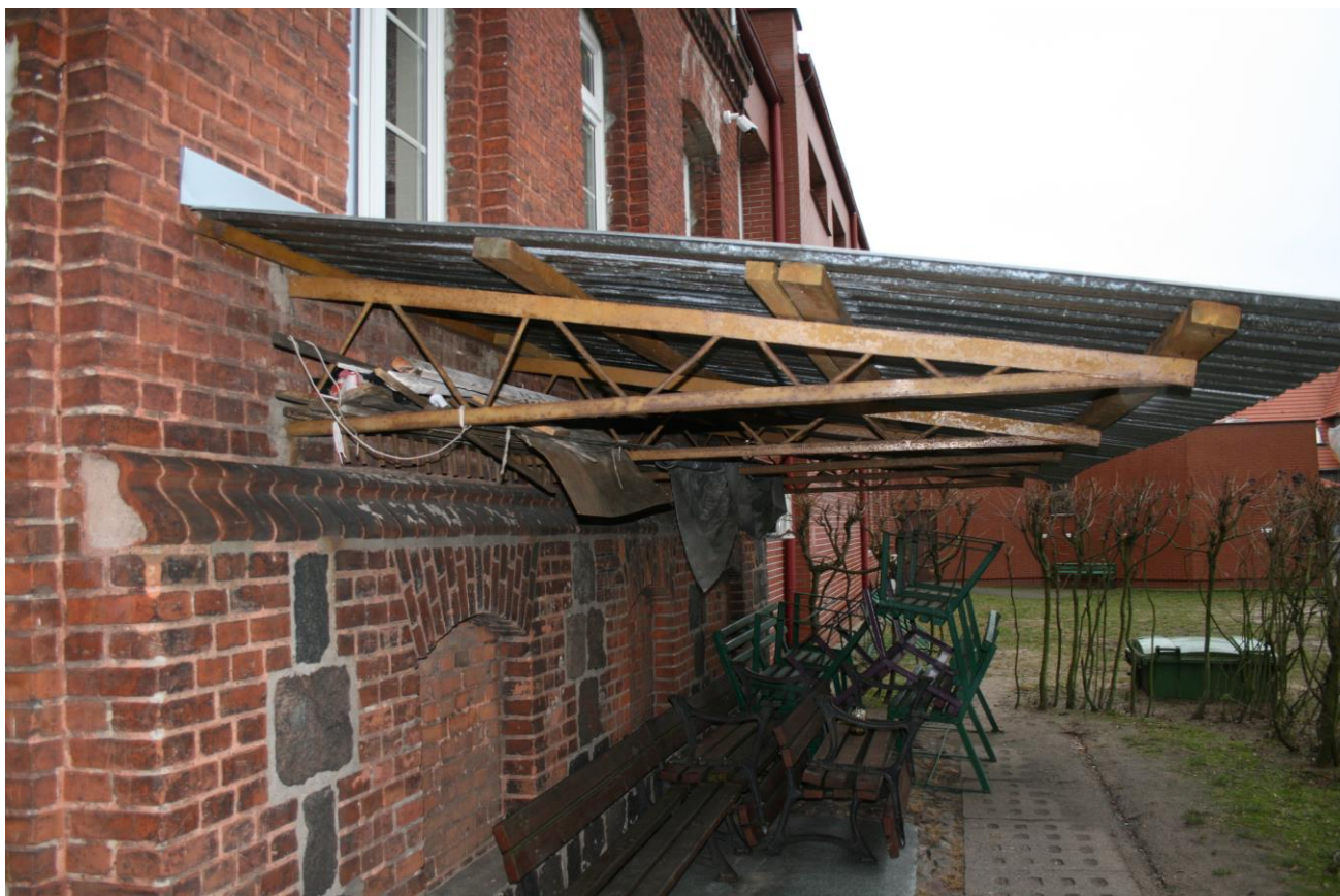
Zdj.30. Zadaszenie zakotwione do muru – od strony elewacji zachodniej
